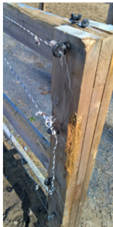
Men om man måste göra en tillfällig knut på stängselledningen i avsaknad av kopplingsstycke, kan man förbättra elflödet genom att demontera metalledningarna på ett kort avstånd vid knuten och koppla ihop dem ordentligt.
